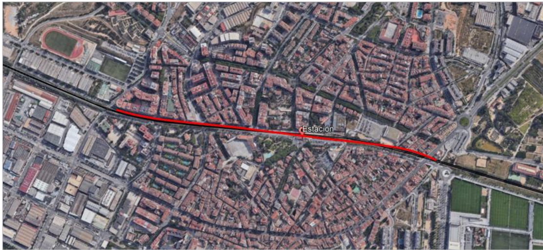
Figura 138.- Vista aèria de la línia al seu pas per Sant Feliu de Llobregat (Barcelona)
