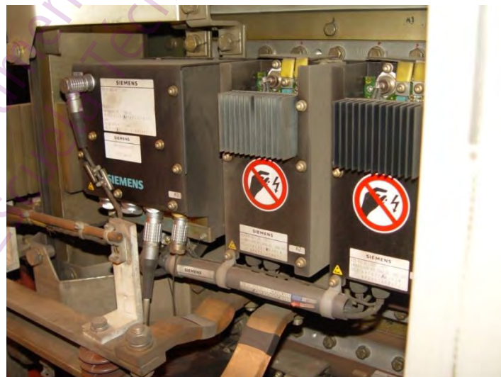
Figura 1-46. Gate Unit. Unidad de disparo tiristores S/252.
